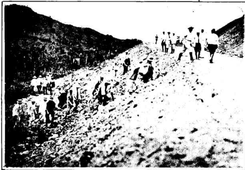
Los excursionistas inspeccionando el tramo más elevado de la carretera central, en el punto por donde atraviesa la Sierra Maestra.
